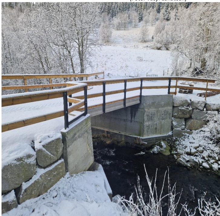
Ferdigbygd bru i Røymarka. Skogsbilvei Lessengmoen
