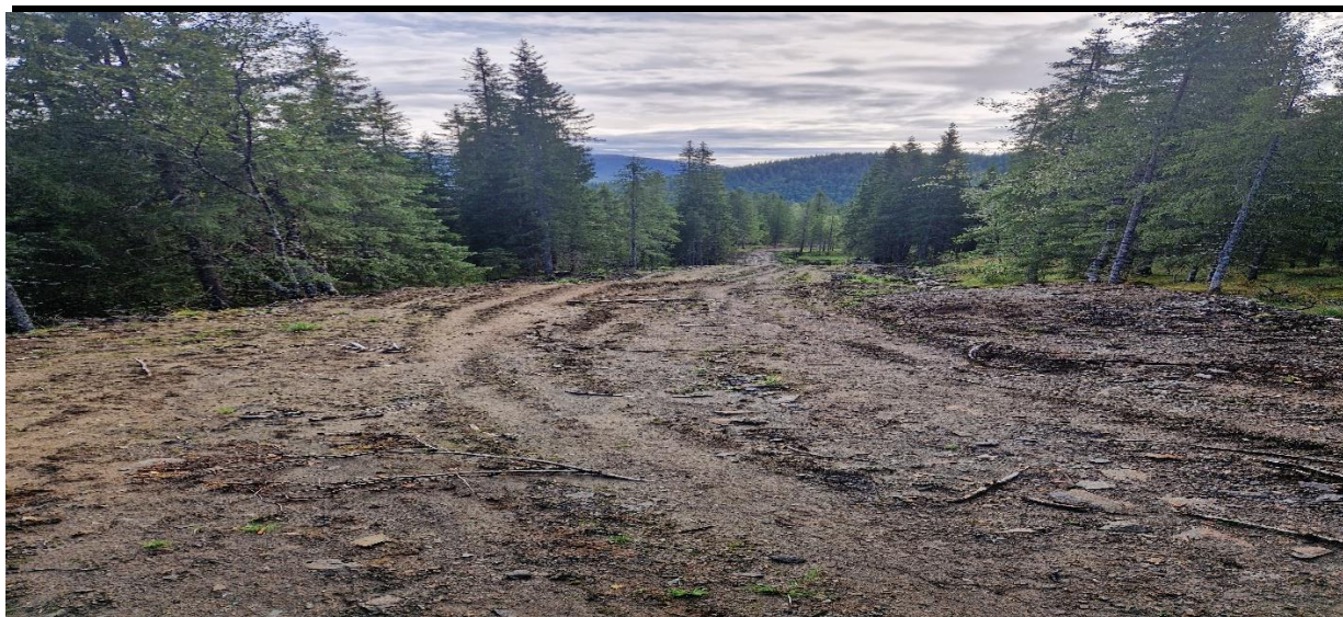
Traktorvei kl 8 Knut Fjellaldselv 90% ferdig
