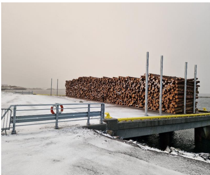
Tømmerkaia er ferdigbygd på Gårdsøya
