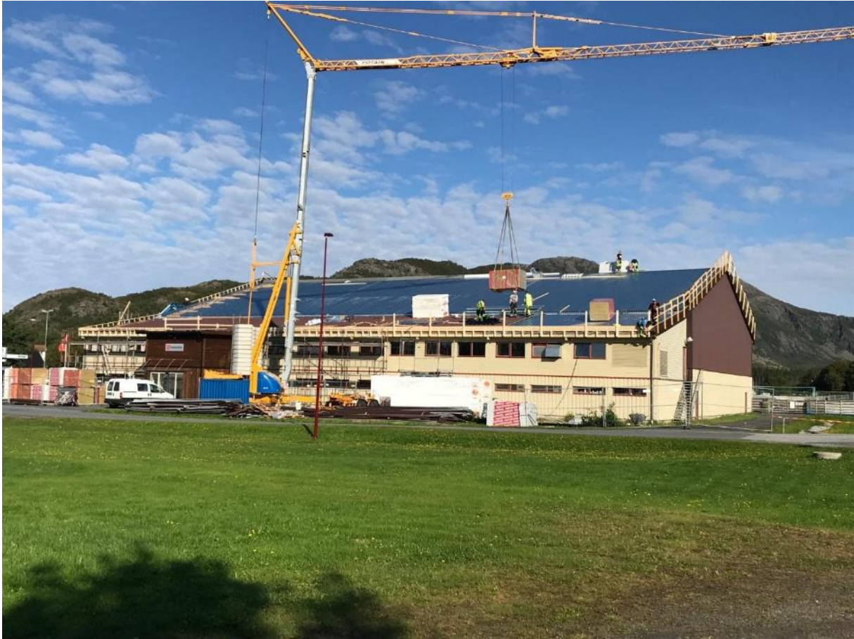
Renovering av Sømna hallen
