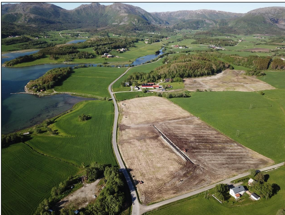
Dalbotn sett fra drone. I forkant drenering hos Kristoffer Kleiven. Foto: Kristoffer Kleiven
