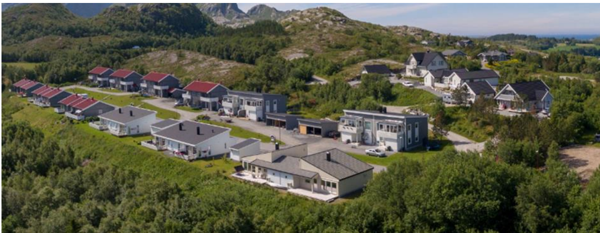
Oppstart med anleggsarbeidene i Buskhammeren Boligfelt
