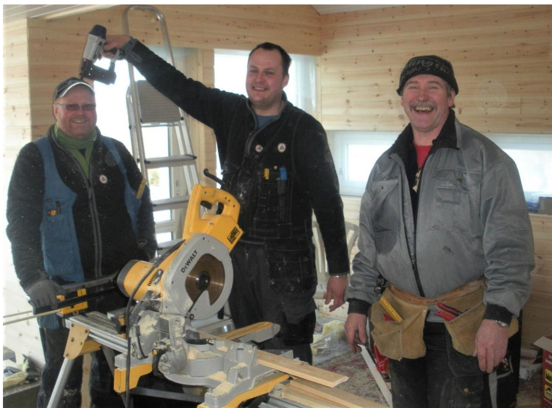
Vi har flere snekkerbedrifter i kommunen. Her er Sømna Bygdeservise i arbeid med et fritidshus ved Buvik. Fv: Roy Helge Dahle, Jim Hestås og Dag Bjørnar Grønmo. Foto: Nils Nyborg
