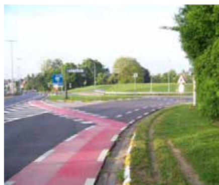
Øverste foto viser eksempel på opparbeiding av gang- og sykkelveg. De øvrige foto viser eksempler på ferdigstilte godt merkede gang- og sykkelveger kant-i-kant med hovedvegen.
